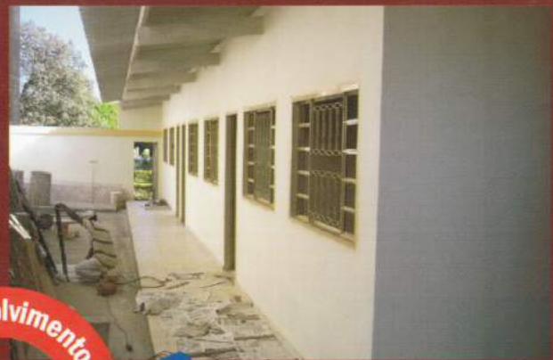
Ampliação das salas da Escola Municipal de Música Maestro Elias Porfírio de Azevedo
